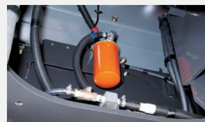
Точки контрольного осмотра, расположенные за нижним кожухом
