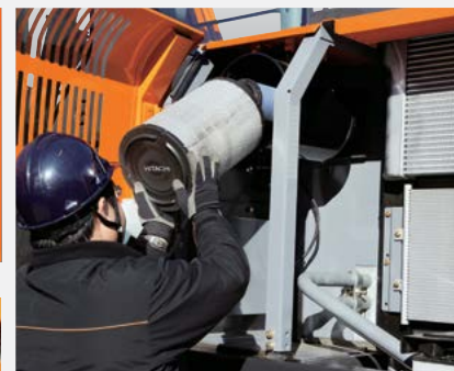
Двойные фильтры очистки воздуха
