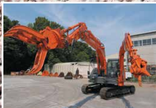
Экскаватор ASTACO с двумя стрелами для комплексной работы
