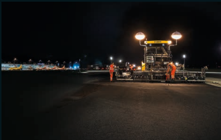
Ночные работы в аэропорту: великолепные результаты укладки при нехватке времени.
